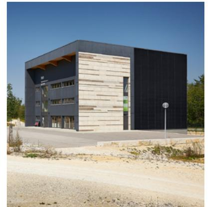
Neubau eines modernen Kletterzentrums des Deutschen Alpenvereins mit einer 169 m<sup>2</sup> großen Solarfassade auf einer Holzunterkonstruktion an der Südseite. Der JURABLOC besticht durch die eindrucksvolle Kombination aus Naturstein-Fassade und unterschiedlichen Materialien.
