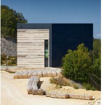
Neubau eines modernen Kletterzentrums des Deutschen Alpenvereins mit einer 169 m² großen Solarfassade auf einer Holzunterkonstruktion an der Südseite. Der JURABLOC besticht durch die eindrucksvolle Kombination aus Natursteinfassade und unterschiedlichen Materialien.
