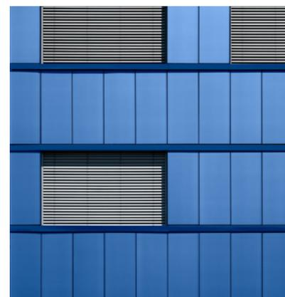
Unter laufendem Betrieb erfolgte die energetische Sanierung des logistischen Verteilenzentrums Volg. Ergänzend zu den Dach-PV-Anlagen erhielt die Westseite mit Standard- und längenreduzierten Modulen eine Solarfassade in Kundenfarbe „Volgblau“.
