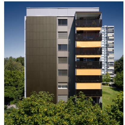
Gesamtsanierung des 1971 erbauten Wohnkomplexes an der Melchiorstraße. Zwei bronzefarbene Solarfassaden an der Süd- und Westseite des Hochhauses produzieren einen Teil der Energie und Wärme und verbessern die Ökobilanz.
