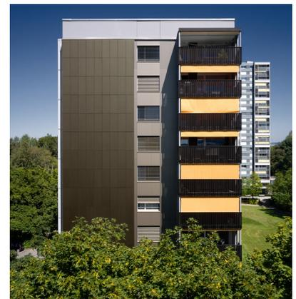
Gesamtsanierung des 1971 erbauten Wohnkomplexes an der Melchiorstrasse. Zwei bronzefarbene Solarfassaden an der Süd- und Westseite des Hochhauses produzieren einen Teil der Energie und Wärme und verbessern die Ökobilanz.
