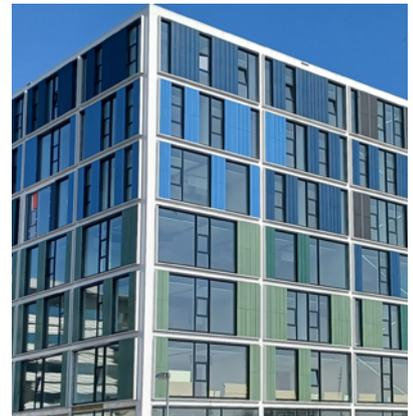
Dieses multifunktionale Gebäude der Universität Amsterdam ist so konstruiert, dass es flexibel, nachhaltig und demontierbar ist. Bei der modularen Fassadenkonstruktion wurden farbige Keramikelemente mit anthrazitfarbenen SKALA-Modulen kombiniert.
