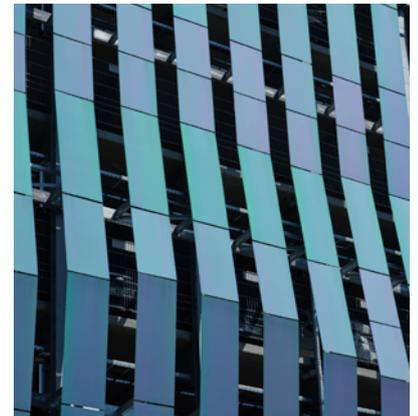
Bei unserem ersten Hybrid-Projekt wurden am Neubau des Parkhauses gebäudeintegrierte Photovoltaik und Aufdach-Solaranlagen kombiniert, um damit einen großen Teil des Strombedarfes des DHL-Campus decken zu können.
