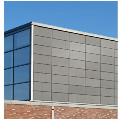
An der neuen Dreifeld-Sporthalle der Gesamtschule in Gronau sorgen als optischer Kontrast zur roten Klinkerfassade im Erdgeschoss 536 anthrazitfarbene SKALA-Module an drei Seiten des Obergeschosses für eine nachhaltige Stromerzeugung.
