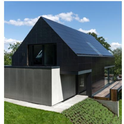
Solararchitektur der Meisterklasse an diesem beeindruckenden Plusenergiehaus. Die mit Alucobond verkleideten SKALA-Module ergänzen am Süddach und der Südfassade das umgebende Schiefermaterial zu einem einheitlichen Gesamtbild.
