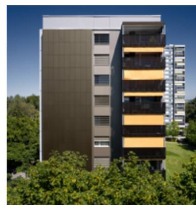
**Gesamtsanierung des 1971 erbauten Wohnkomplexes an der Melchiorstrasse. Zwei bronzefarbene Solarfassaden an der Süd- und Westseite des Hochhauses produzieren einen Teil der Energie und Wärme und verbessern die Ökobilanz.**
