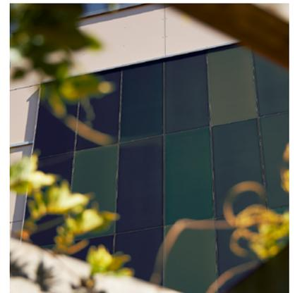
Die Gebäudehülle wurde durch Aufstockung mit Attika-Wohnungen gesanert. Das Objekt mit dem Energielabel AA+ erzeugt Strom und Warmwasser über PV-Module auf dem Dach, an Balkonbrüstungen sowie über zwei SKALA-Solarfassaden.
